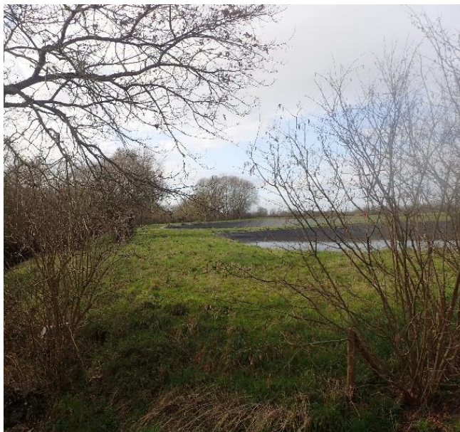
Photo 4 : Lagunes de la STEP Route d'Erbray. Source : GAMA Environnement
