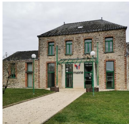
Photo 26 : Mairie de Louisfert. Source : Géostudio
