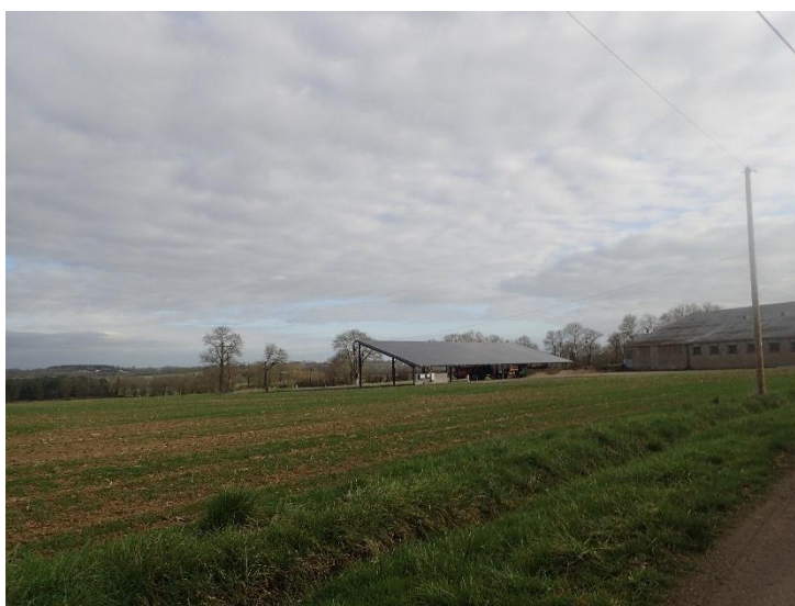
Photo 5 : Panneaux photovoltaïques sur toiture d'un bâtiment agricole sur la commune de Louisfert. Source : GAMA Environnement
