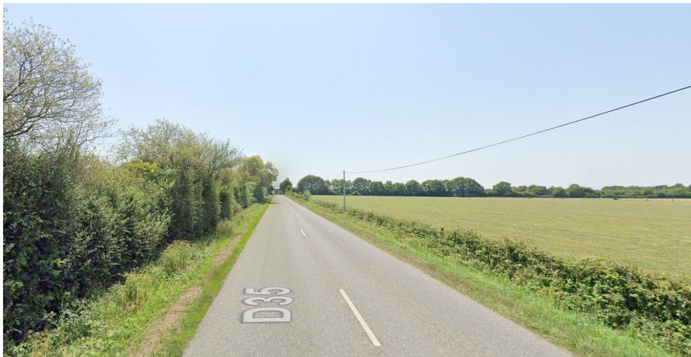
Photo 21 : La RD35, élément fragmentant de la TVB. Source : Google Maps
