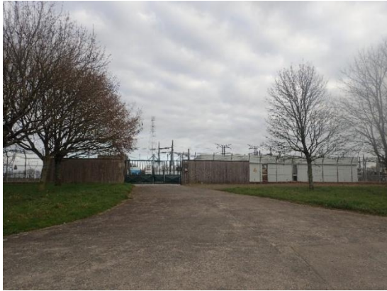
Photo 39 : Entrée du poste électrique à Louisfert. Source : GAMA Environnement
