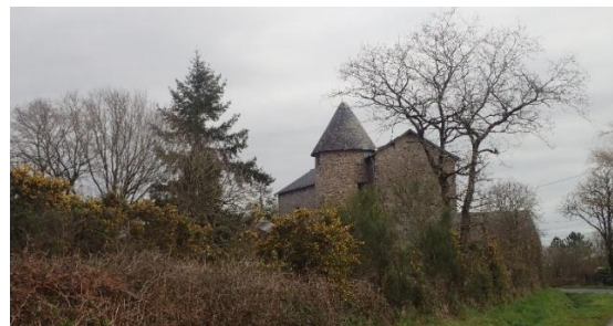
Photo 30 : Bâtisse au Bois Vert. Source : GAMA Environnement
