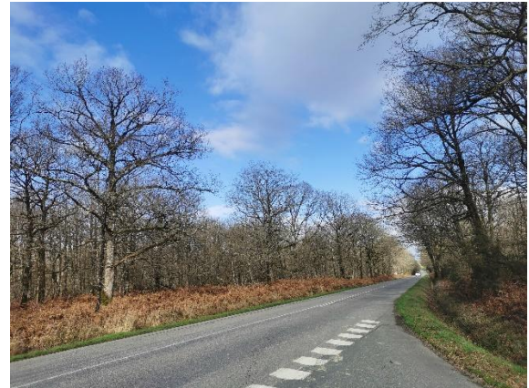
Départementale D35. Source : Géostudio
