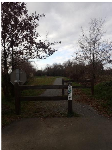
Voie verte à Louisfert, en direction de Saint-Vincent-des-Landes. Source : GAMA Environnement
