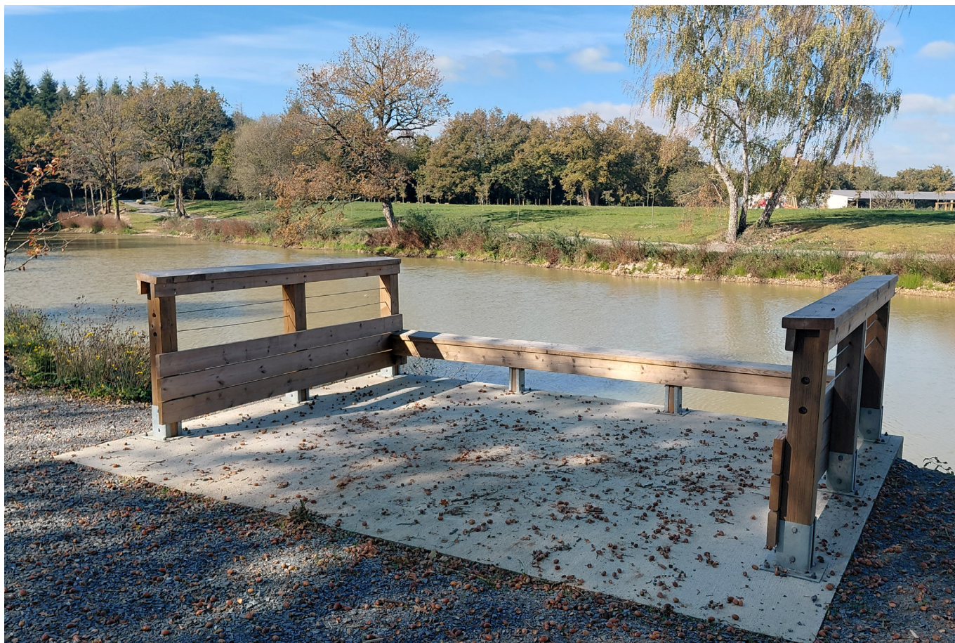
Tertre Rablais - Après travaux
