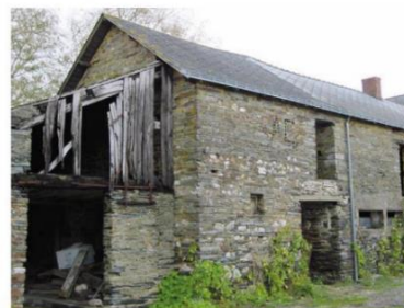
Le corps de ferme avant travaux
