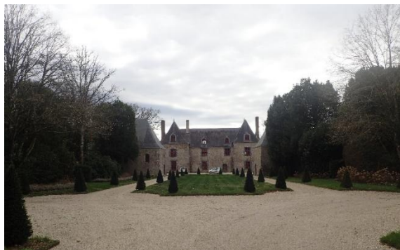
Photo 27 : Château de Caratel. Source : GAMA Environnement
