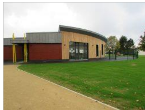
Accueil périscolaire - Louisfert
